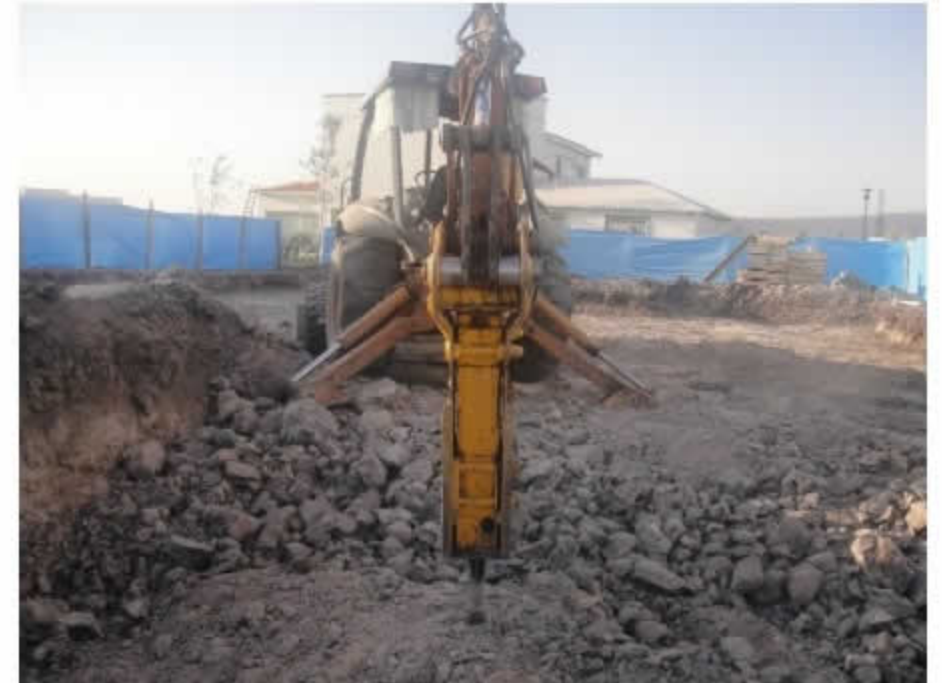
MEGA 416 TRABAJANDO EN OBRA
